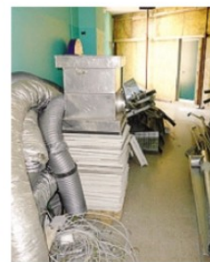
Il cantiere in corso
