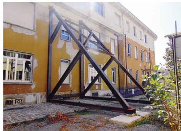
Un dettaglio dell'opera di consolidamento realizzata all'ospedale
