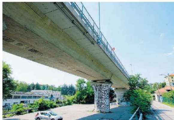
L'azienda Mavi di Roma potrà iniziare i lavori di consolidamento e messa in sicurezza del Viadotto
