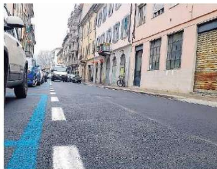
Il nuovo asfalto di via Cadorna, che è stato steso di notte negli ultimi giorni
