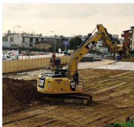
Una ruspa al lavoro tra via Milano e via Lario
