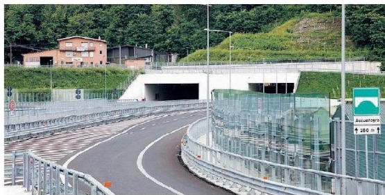
L'accesso al tunnel del primo lotto della Tangenziale di Como, che conduce verso l'Autolaghi (A. Nassa)
