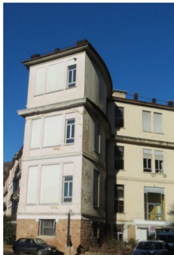
L'ospedale e, a destra, l'ingresso del complesso sanitario nel territorio di Cuasso al Monte (foto Bilz)
