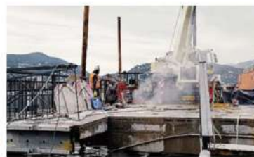
La demolizione della zona della vecchia biglietteria BUTTI
