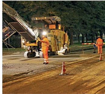
La fresatura è necessaria per la posa del nuovo manto d'asfalto
