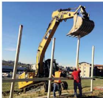
Il cantiere è appena iniziato, ma le ruspe sono già all'opera
