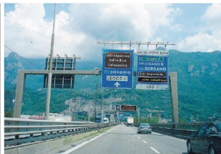
La strada statale 36 del Lago di Como e dello Spluga (nella foto un tratto) è lunga 141 chilometri
