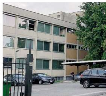
L'ingresso dell'Istituto Romagnosi di Erba
