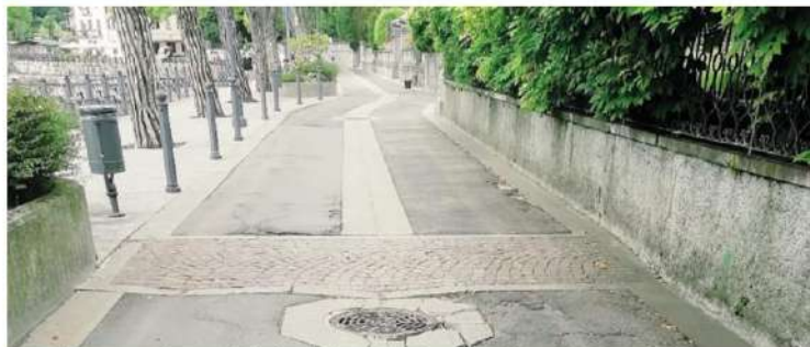
Il tratto di lungolago Lomazzi a Lenno, dove da domani inizieranno i lavori per la messa in sicurezza della Greenway
