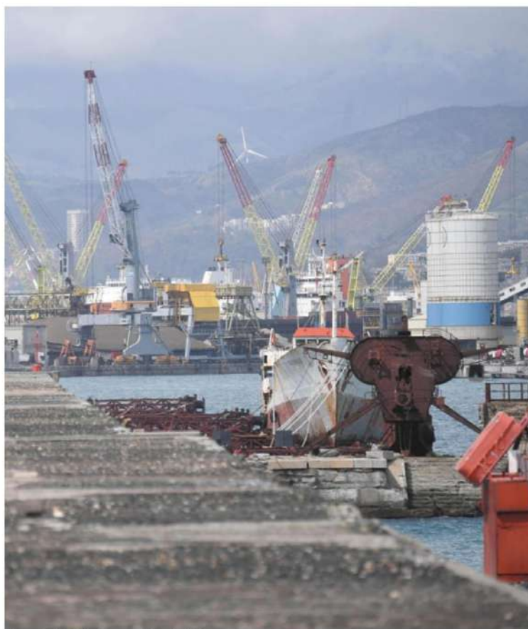
Una parte della diga foranea del porto di Genova ANSA
