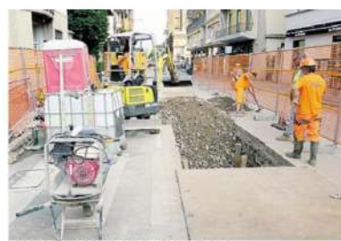
I lavori per sostituire le tubature. FOTO BARTESAGHI
