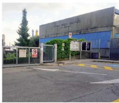
L'istituto comprensivo Kennedy di via Porro
