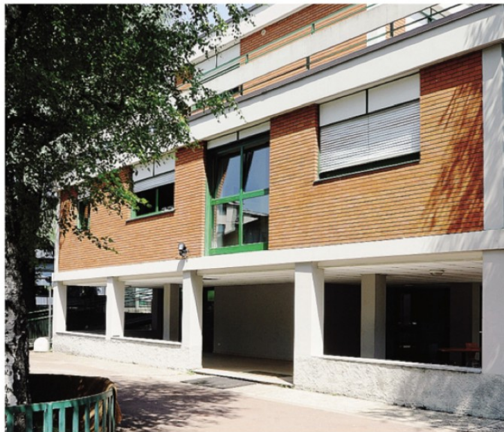
La struttura che ospitava i minori a Tavernola, in via Vertua Gentile, chiusa nell'ottobre del 2015
