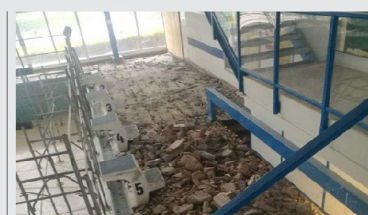
L'interno dell'impianto di Casate, dove sono in corso i lavori nella piscina
