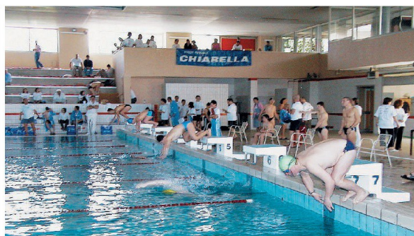
Tutti vietati alla piscina olimpica di Muggiò da ieri. Problemi per alcune parti del controsoffitto, giudicate instabili
