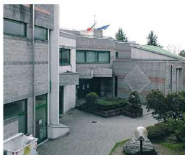
Il complesso con le scuole elementari e medie di Senna Comasco
