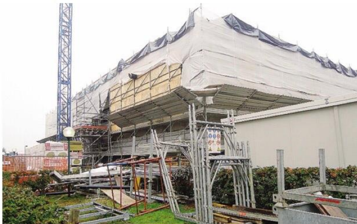
Il cantiere per la realizzazione delle nuove sale operatorie sopra il Pronto soccorso
