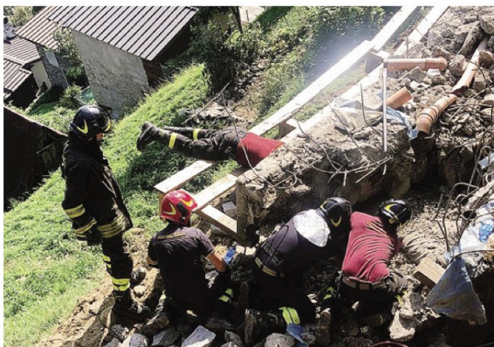
Il drammatico intervento dei vigili del fuoco sul cantiere della pista ciclabile in località Oggja
