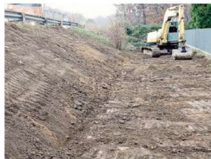
La ruspe al lavoro a lato di via Como prima dell'asfaltatura finale
