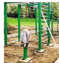
I lavori in corso
