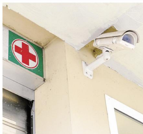
Una delle telecamere posizionate al Pronto soccorso di Cantù
