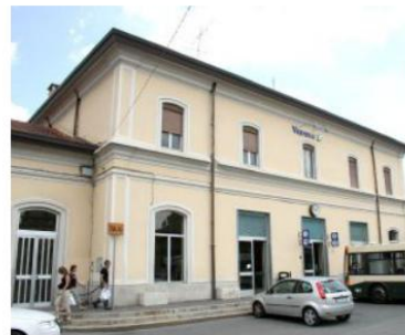
La stazione delle Ferrovie dello Stato (foto Archivio)
