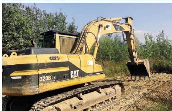
Si utilizzano direttamente le ruspe per rimuovere tutta la vegetazione cresciuta nel cantiere
