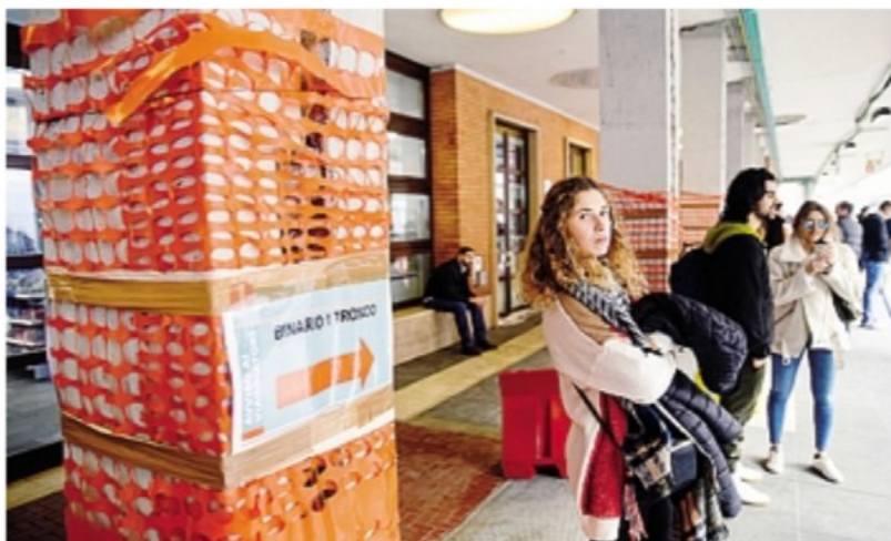
Lavori in corso in stazione, trasformata in un cantiere
