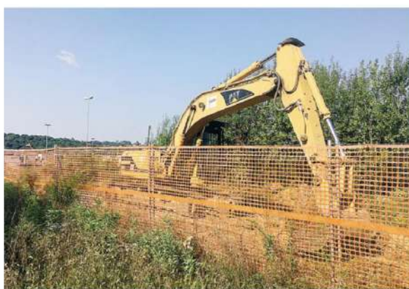
Sono tornate le ruspe in corso Europa: toglieranno le piante nel cantiere per permettere gli ultimi rilievi
