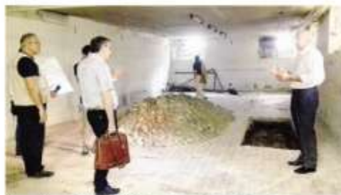
Il sopralluogo tecnico dell'altro giorno al piano interrato
