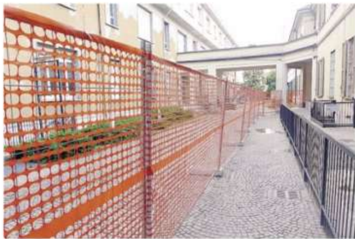
Il blocco B dell'ospedale "Felice Villa" di Mariano: al via i lavori di consolidamento e restauro. FOTO BARTESAGHI
