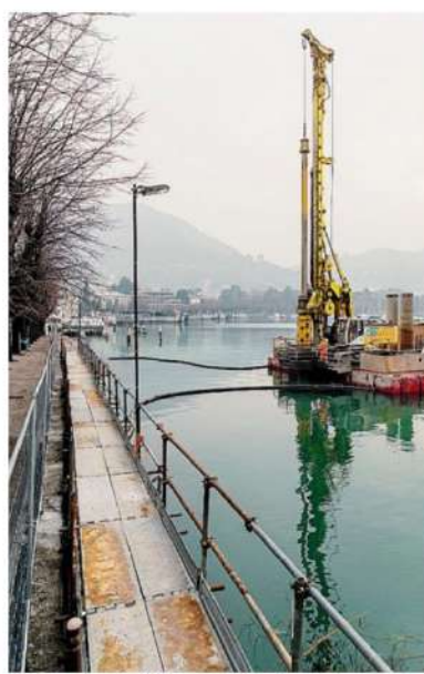
Lavori in corso anche ieri, in zona Sant'Agostino. BUTTI
