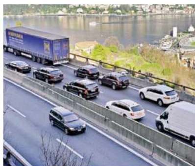
L'autostrada che collega Como alla Svizzera
