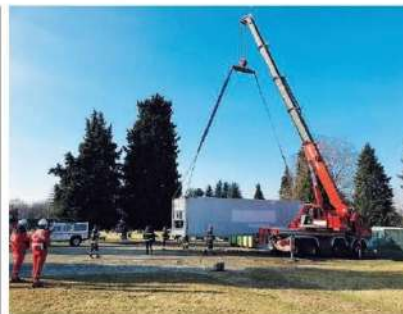
Una fase dei lavori di posizionamento del container all'interno del cimitero di Camerlata
