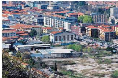
Una veduta dall'alto dell'area dismessa per la quale Como ancora attende soluzioni
