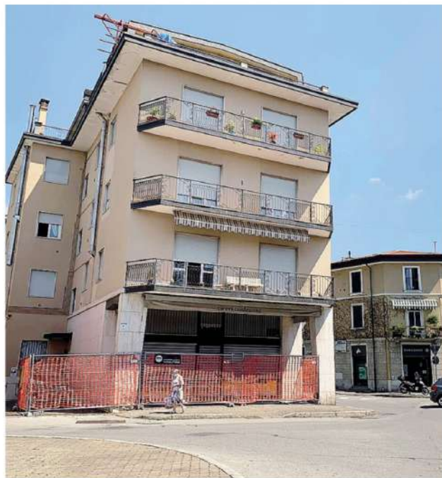
Un cantiere fermo da tempo in piazza Mercato, simbolo della crisi del settore
