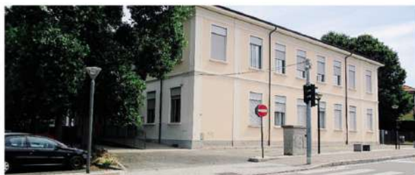
La vecchia scuola sarà abbattuta alla conclusione dei lavori
