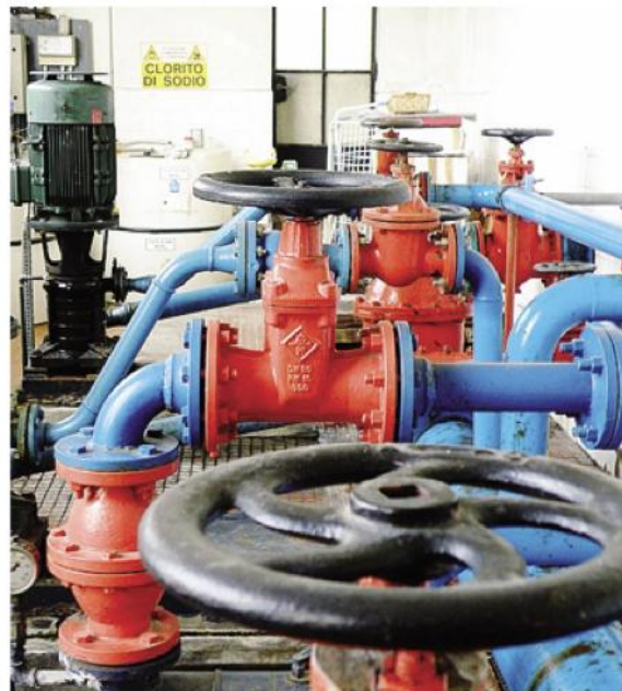
La centrale di Cascina Amata dell'acquedotto di Cantù
