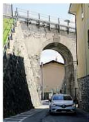
Il ponte di via Castelletti
