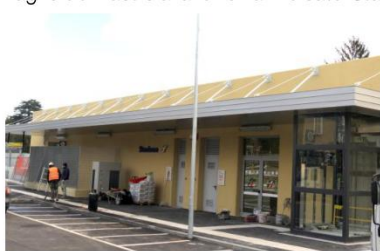
La nuova stazione di Induno Olona lungo la tratta (foto B102)
