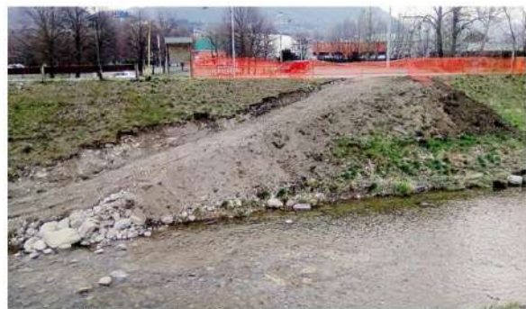
I lavori agli argini del Lambro nel tratto vicino al centro sportivo Lambrone. BARTESAGHI
