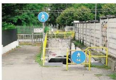
Il nuovo tratto andrà a confluire in quello già realizzato in via Meda
