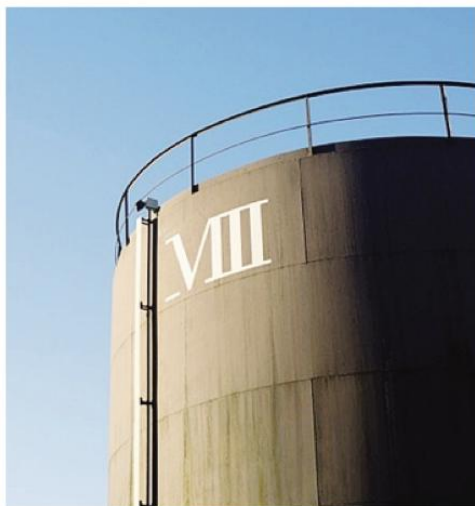
Lo stabilimento di Mantero Seta alle porte di Como
