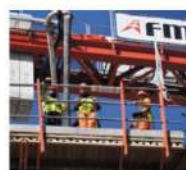
Il cantiere di Levante a Genova
