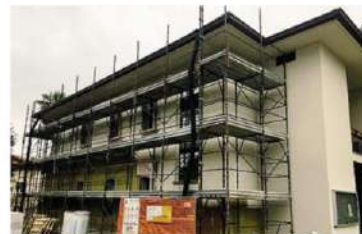
I lavori di efficientamento in corso al municipio di Cucciago
