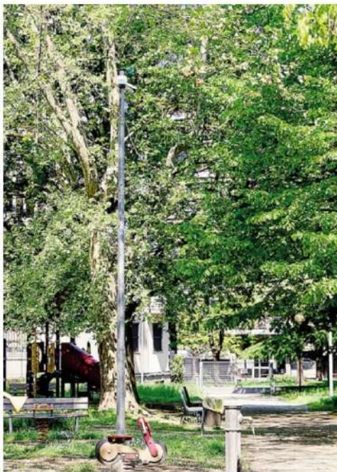
Le nuove telecamere installate in via Anzani e via Leoni BUTTI
