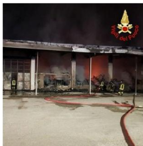
Le immagini degli ingenti danni dopo l'incendio
