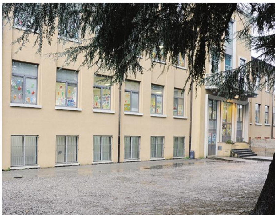
L'esterno delle scuole elementari e della mensa di Cadorago
