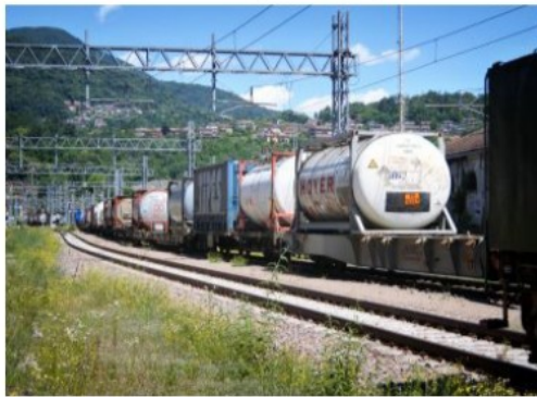
Residenti e commercianti chiedono di avere più informazioni sull'opera ferroviaria: sopra il passaggio a livello di via Voldomino
