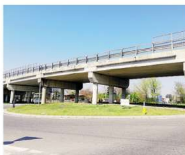
Il Ponte del Lottolo a Mariano Comense
