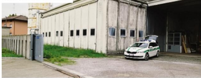
L'intervento della polizia locale al capannone di via Boaresco
