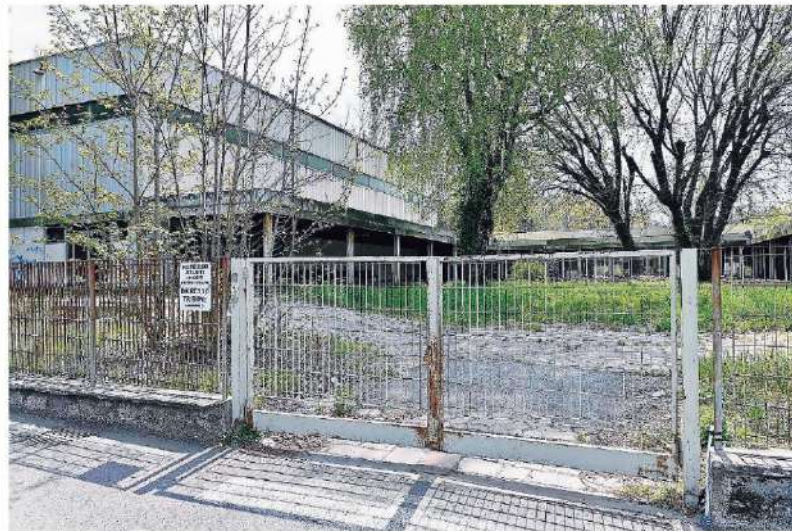
Il palasport di Muggiò, chiuso dalla fine del 2013, è solo uno dei simboli dello stato di abbandono del quartiere da parte dell'amministrazione
