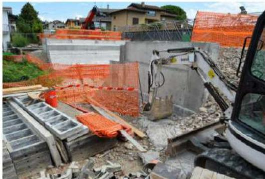
Le due spalle che sosterranno la volta del nuovo ponte che dovrebbe arrivare la prima settimana di settembre secondo quanto annunciato ieri da Ferrovie Nord e, sotto, l'area di cantiere ferma da 17 giorni; oggi è prevista la ripartenza (D.M. B&L)
