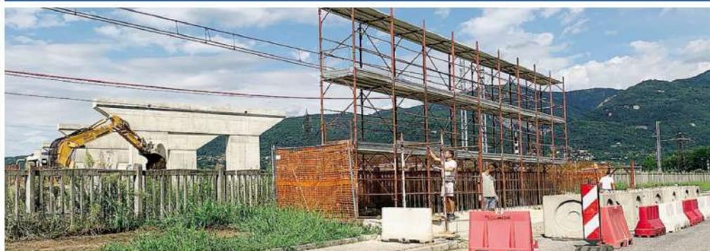
L'intervento in corso per la posa del pilone del cavalcavia ferroviario con il senso unico alternato in via del Lavoro BATTESAGHI
