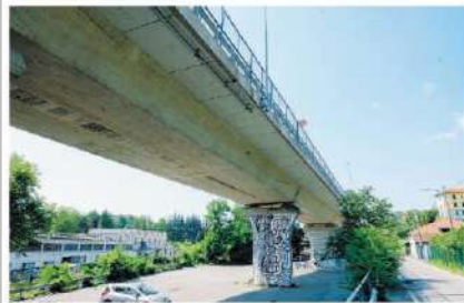
Lavori di consolidamento strutturale sono attesi al viadotto dei Lavatoi, infrastruttura strategica.
