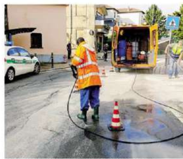
L'operazione di pulizia della strada, resa scivolosa per l'olio
