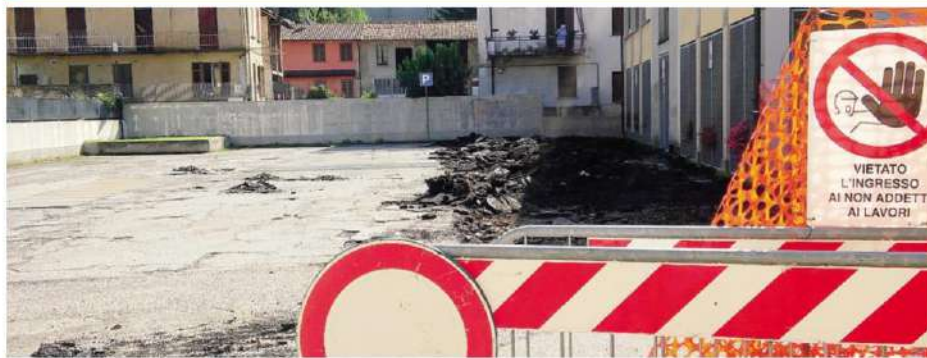
Lavori per il rifacimento del parcheggio in via Vittorio Emanuele, accanto all'oratorio
