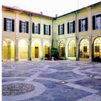
La casa di riposo della Fondazione Borletti di Arosio
