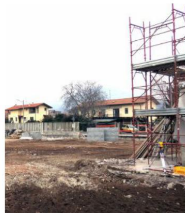
Il cantiere per l'abbattimento dei vecchi capannoni industriali dismessi a Induno Olona (foto B112)
