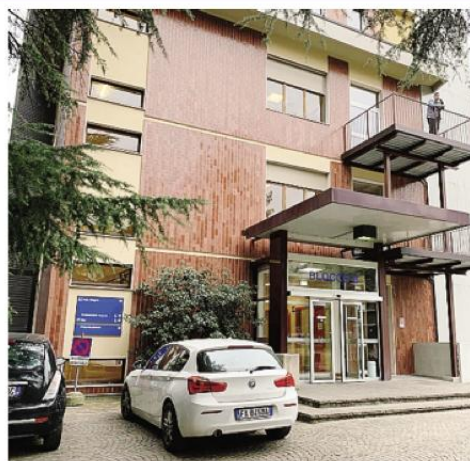
Il blocco B dell'ospedale dove sono stati rubati i macchinari
