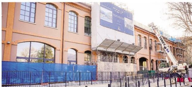
Il cantiere del nuovo hotel nell'area ex Subalpina di via Borgo Vico BUTTI
