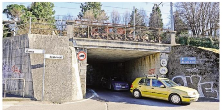
Il sottopasso ferroviario dovrà essere allargato in vista della chiusura del passaggio a livello ARCHIVIO
