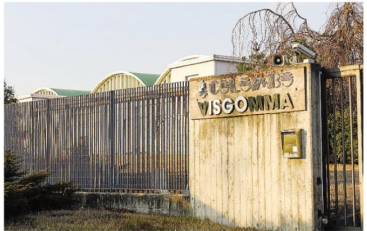
Lo stabilimento Visgomma: è in corso lo sgombero per passare poi all'abbattimento ARCHIVIO
